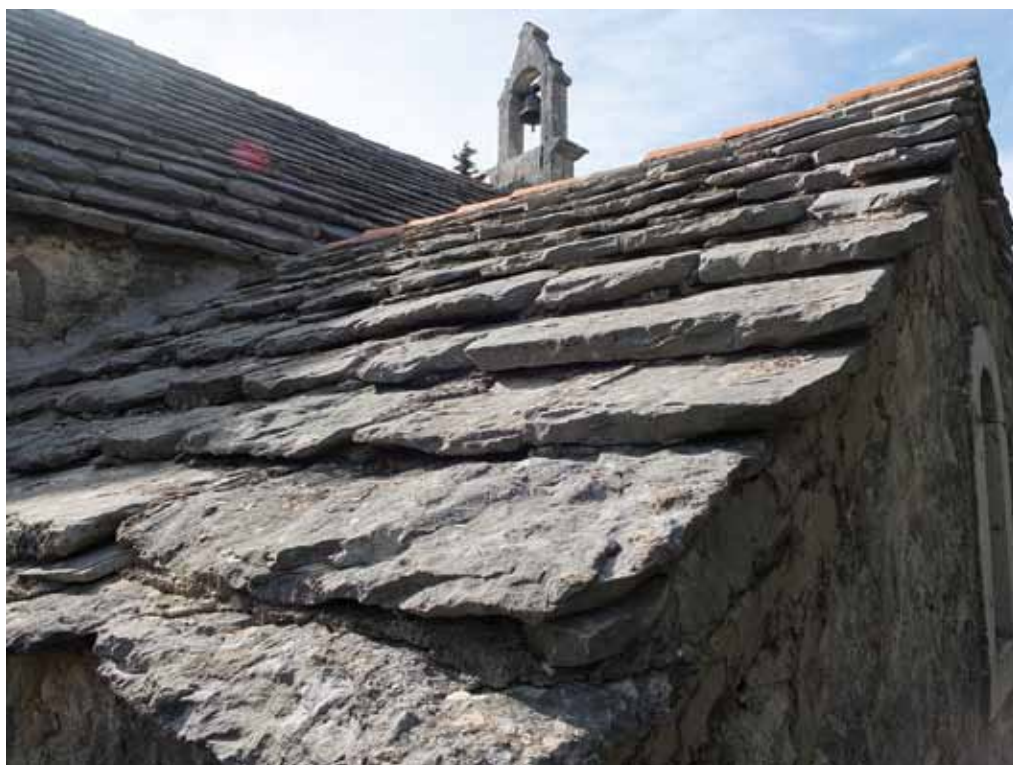
Krovište male crkve / Toiture d'une petite église / The roof of the small church
