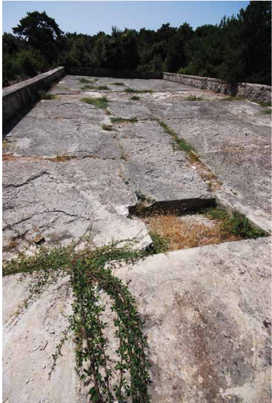
Veliki popločani piover na Gažulu / Grand plan de recueil de l'eau recouvert de pierre à Gažul / Large tiled plover on Gažul
