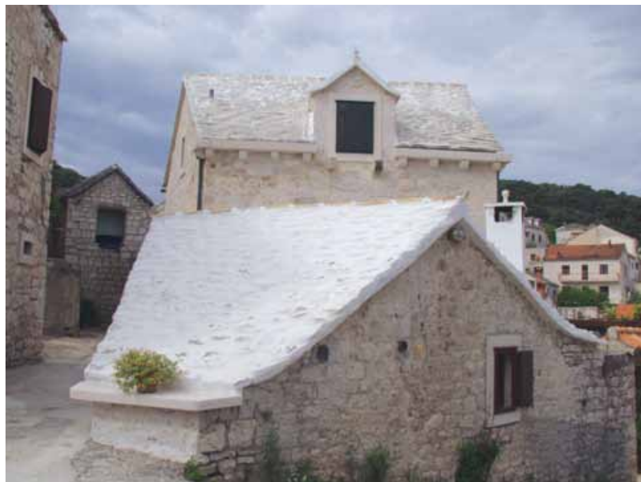
Dvostrešna krovíšta / Toiture à deux pans / Two-sided stone roofs
