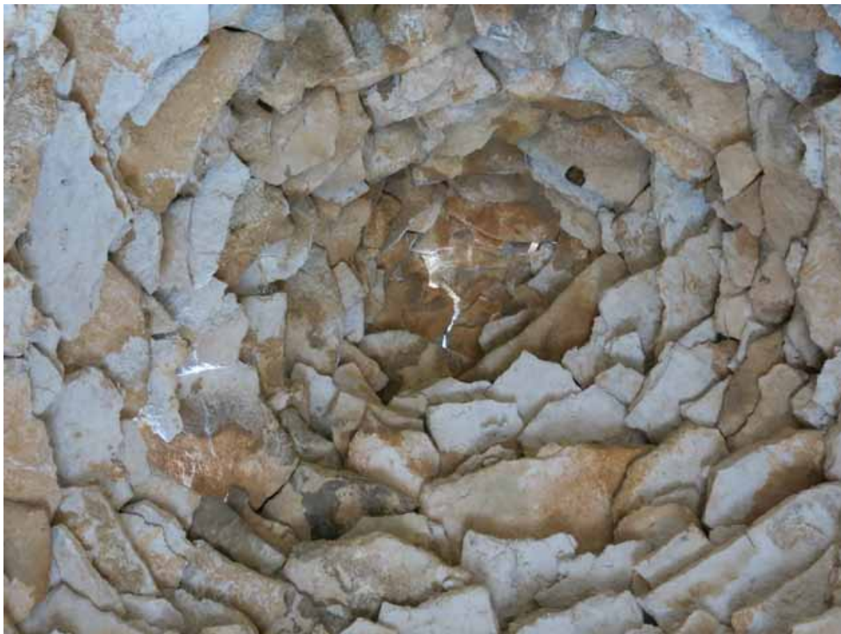
Unutrašnjost krovne kupole bunje / Vue intérieure sur la coupole d'un toit en pierre d'une hutte / Bunja roof dome from inside
