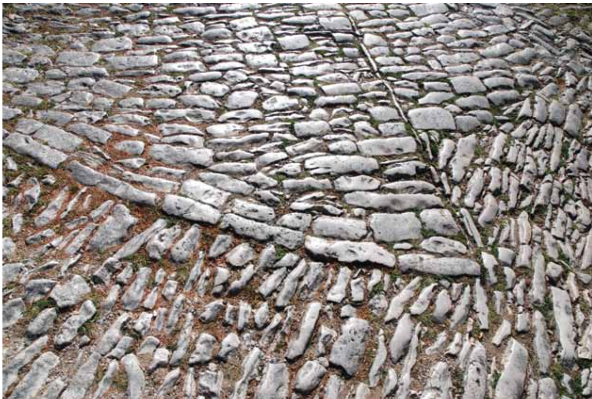
Pločnik od kogula (Pučišća) / Pavement de pierre (Pučišća) / The pavement made of "kogule" (Pučišća)
