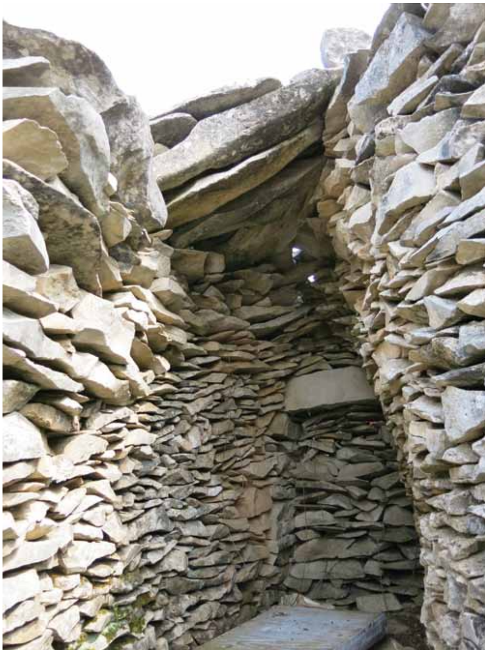
Unutrašnjost skloništa / Vue intérieure d'un abri en pierre / The inside of a shelter
